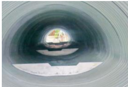
Abbildung 6: Beispiel eines Querstegs in einer Wellstahlröhre (Quelle Webpage Sytec)
