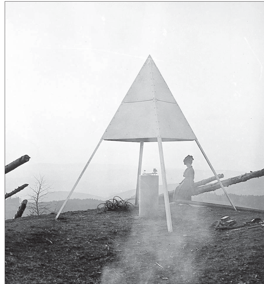
Die Pyramide des Triangulationspunktes 2. Ordnung auf dem Bantiger von 1911. Quelle: Bundesamt für Landestopografie
