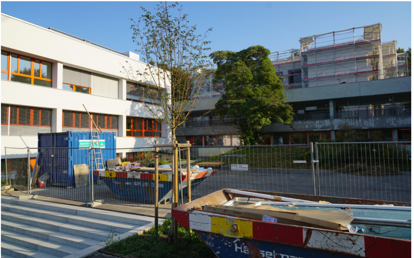
Bild: Sanierung und Umbau Oberstufenzentrum Eisengasse (OzE)
