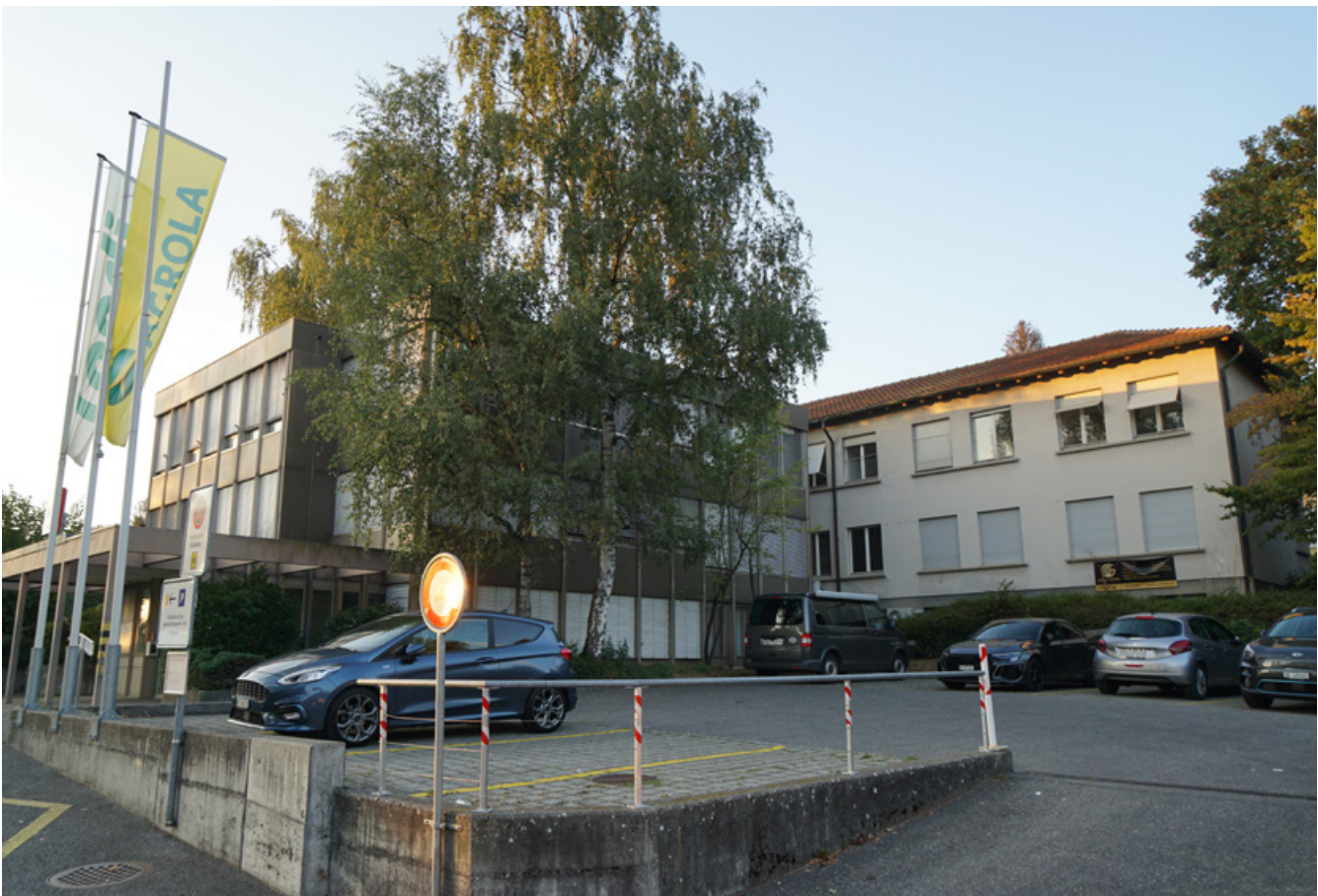
Bild: Arealentwicklung Bahnhof – ehemaliges UBS-Gebäude / Landi
