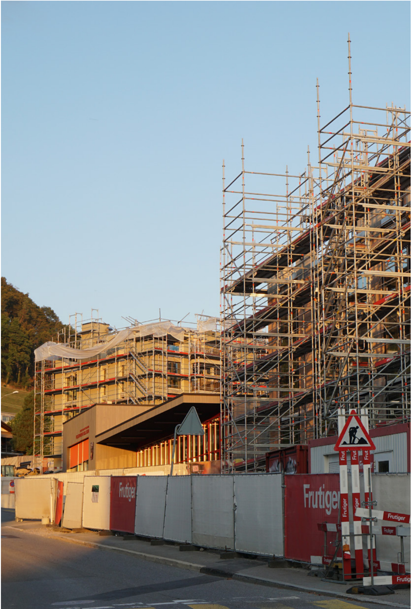
Bild: Baustelle Flugbrunnenareal
