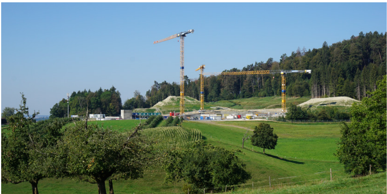
Bild: Grossbaustelle neues Reservoir Mannenberg der Wasserversorgung Region Bern AG (WVRB)
