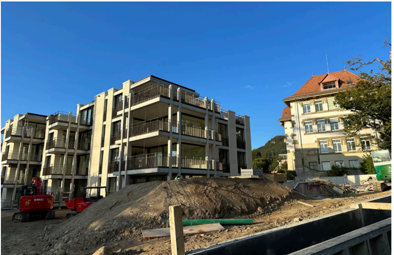
Bild: Baustelle Flugbrunnenareal mit altem Schulhaus an der Flugbrunnenstrasse
